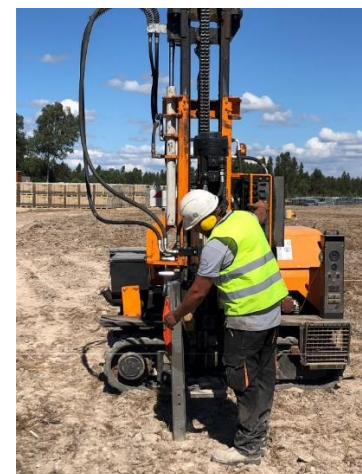
Montagem dos painéis solares
